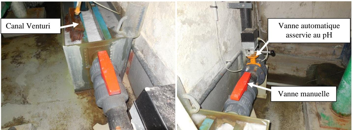
*Canal Venturi (à gauche) et vannes d'isolement manuelle et automatique (à droite)*
