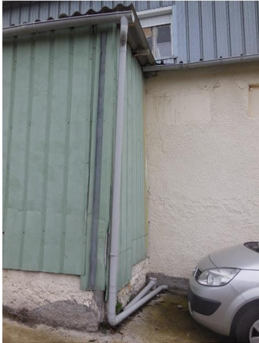
*Gouttière en gargouille récoltant les eaux pluviales de la toiture*
